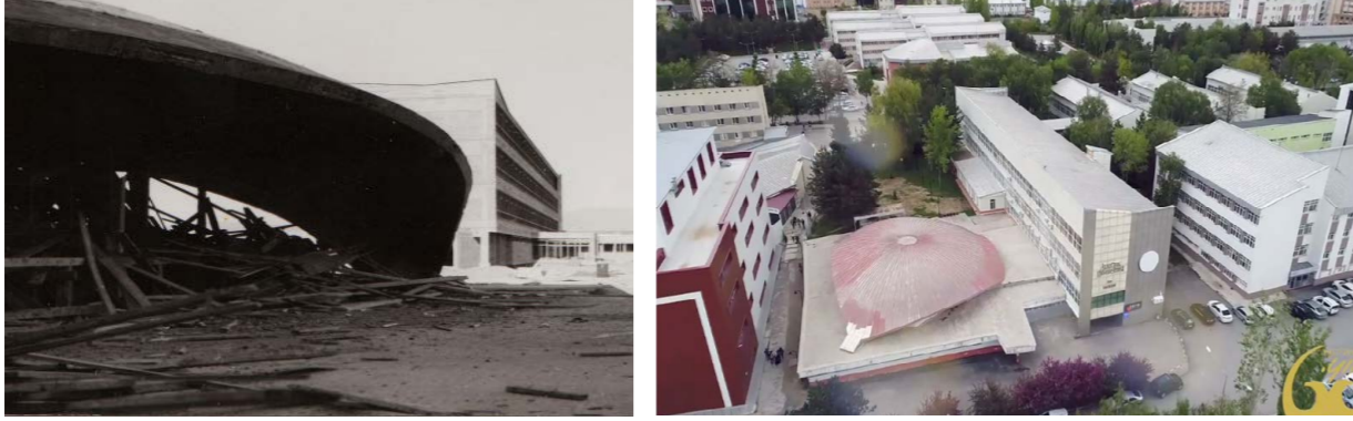
Resim 18. Fen Fakültesi Oditoryumu İnşaatı ve Üstten Görünümü
