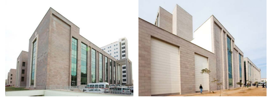
Resim 24. Antalya State Hastanesi Andezit Cephe Kaplama Uygulaması
