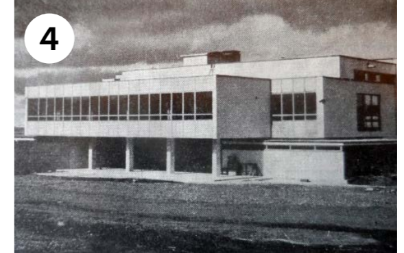
Fen Fakültesi Oditoryumu kabuk inşaatı
