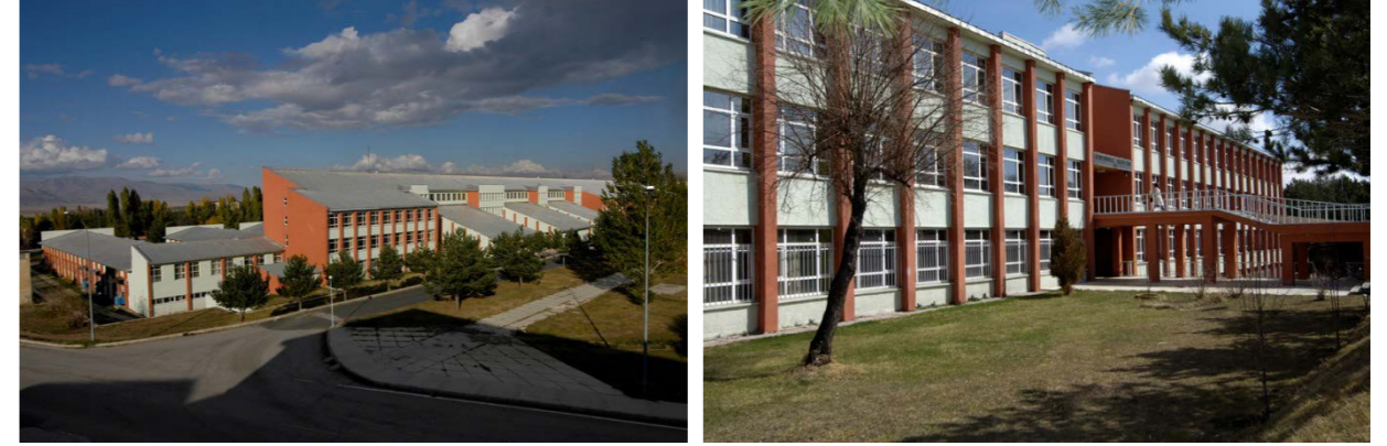
Resim 20. Mühendislik Fakültesi güney cephesinden fotoğraflar
