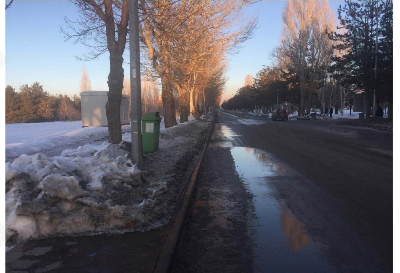
Resim 10. Ataturk Üniversitesi Yerleşkesinde Bazı Kaldırımlarda Bulunan Aydınlatma Elemanları, Çöp Kutuları ve Yönlendirme Levhaları Kar Temizliğini Engelleyebilmektedir. 2016 Yılından Bir Görünüm
