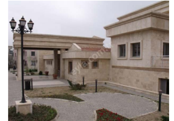
Resim 24. Antalya State Hastanesi Andezit Cephe Kaplama Uygulaması
